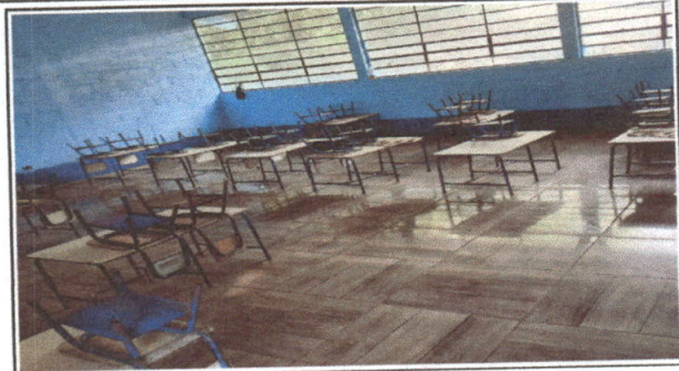
Foto 2: se observa en la fotografia la finalizacion de instalacion de ceramico
