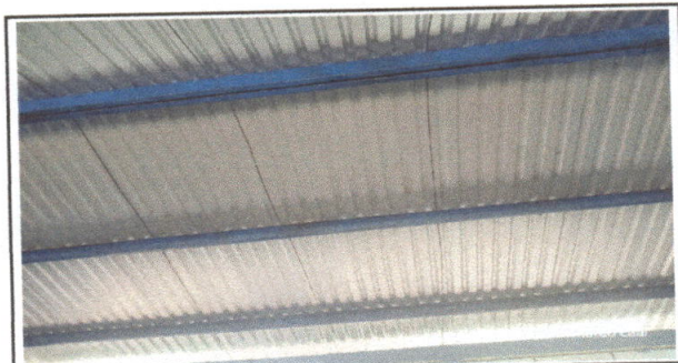
Foto 6: se observa la finalizacion de la aplicación de pinturas en las costaneras
