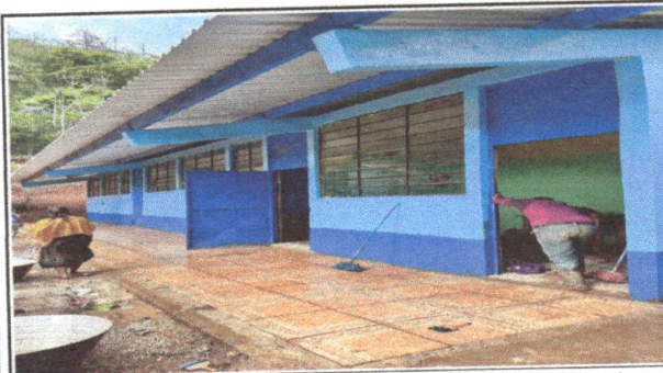
Foto 3: Se evidencia en la imagen la finalizacion de instalacion de piso en el corredor y la palicacion de pintura
