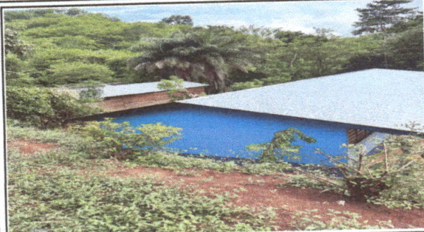
Foto1: Luego de haber realizado los diferentes procesos de instalacion de laminas troqueladas
